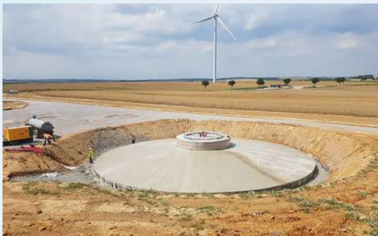
Figure 5 : Fondations d'une éolienne
